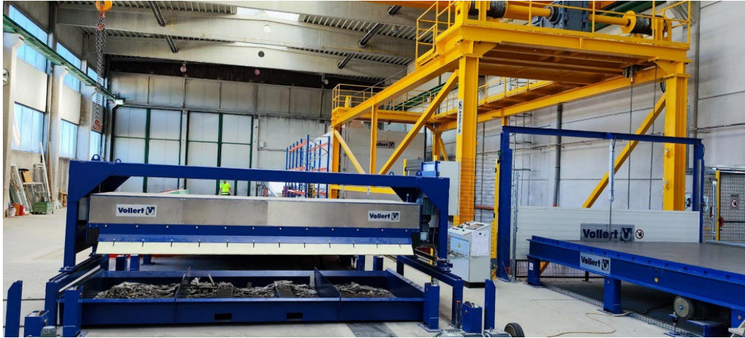
Photo 3 : La nouvelle technique des machines a été adaptée de manière optimale à l'espace existant.
