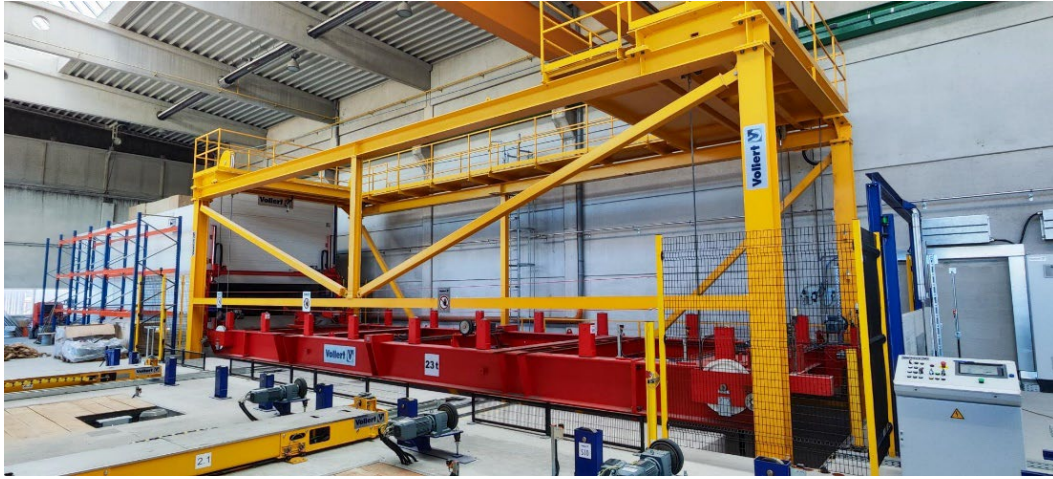
Figura 1: A câmara de cura totalmente isolada e a unidade de armazenamento e recuperação formam a peça central da nova instalação de produção de parede dupla da Josef Lehner GmbH.
